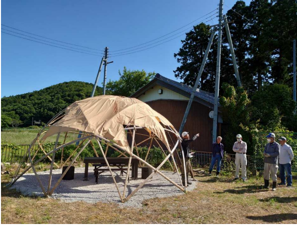
「四季彩ドーム」の建築
